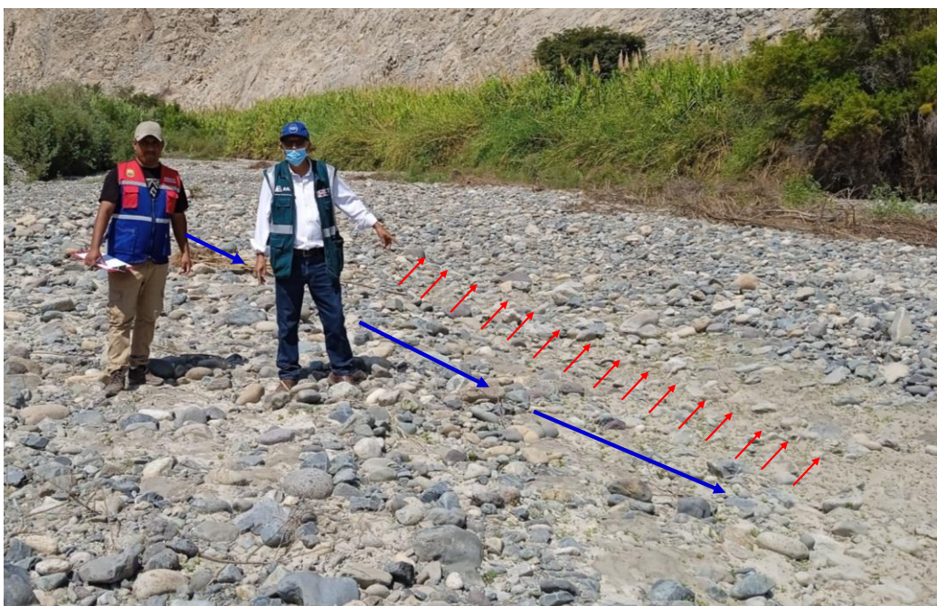
FIGURA N°03: EN LA TEMPORADA DE MAXIMAS AVENIDAS EL RÍO HUARMEY, SE DESBORDA, POR LA MARGEN DERECHA, EN EL SECTOR HUAMBA BAJA, DISTRITO DE HUARMEY - HUARMEY, CUYO TRAMO SE ENCUENTRA COLMATADO Y DESPROTEGIDO, VULNERABLE A LAS VELOCIDADES EROSIVAS DEL RÍO.
