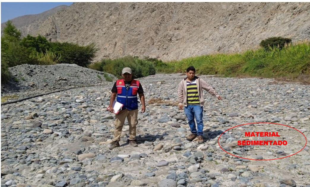
FIGURA N°02: MATERIAL COLMATADO EN EL CAUCE DEL RÍO HUARMEY, CON UNA PROFUNDIDAD PROMEDIO DE 1.0 M. ESTO PROVOCA QUE DESBORDAMIENTO DEL RÍO SEA MAS INMINENTE.
